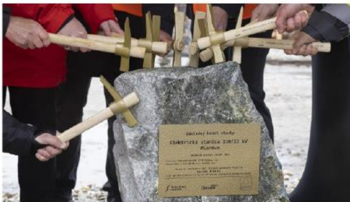
Výstavba novej elektrickej stanice Mierovo.
