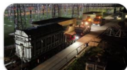
Dovoz nového transformátora T 402 do Est P. Biskupice.
