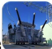
Inštalácia nového transformátora T402 v Est P. Biskupice
